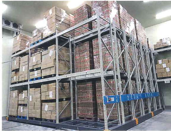
冷凍倉庫 (電動ラック完備)
